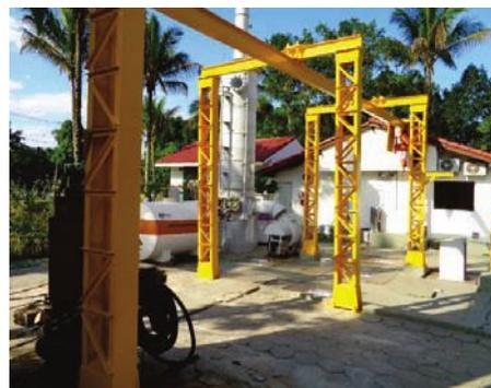
Pintura e manutenção da monovia da Estação Elevatória Final de Esgoto
