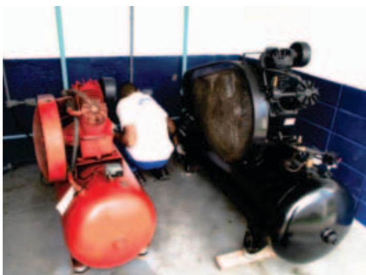
Substituição de motor do compressor do sistema de tratamento de esgoto
