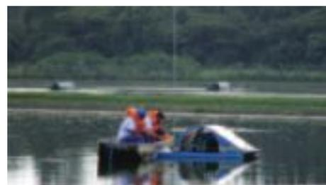
Substituição de flutuantes aeradores em lagoa da Estação de Tratamento de Esgoto
